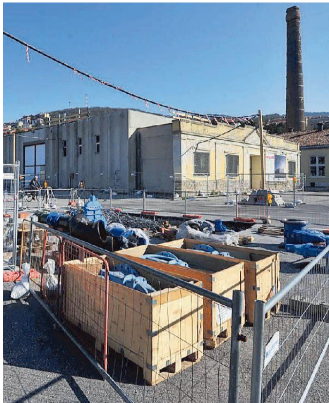
Lavori nella zona compresa tra i Magazzini 27 e 28
